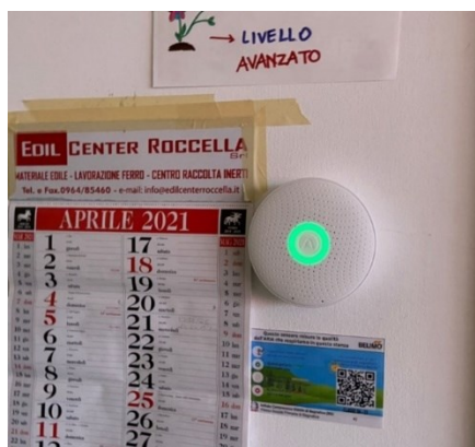
Figura 7 - Sensore IAQ con indicatore luminoso in funzione
