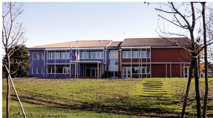
Figura 6 - Scuola Primaria di Bagnatica, lato Ovest
