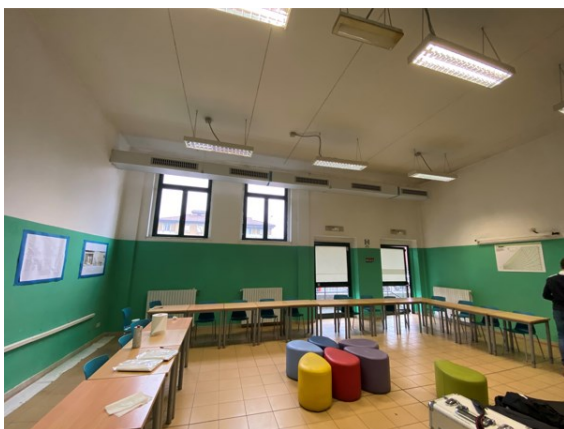
Figura 11 - Aula TER.2 e condotta di mandata dell'aria
